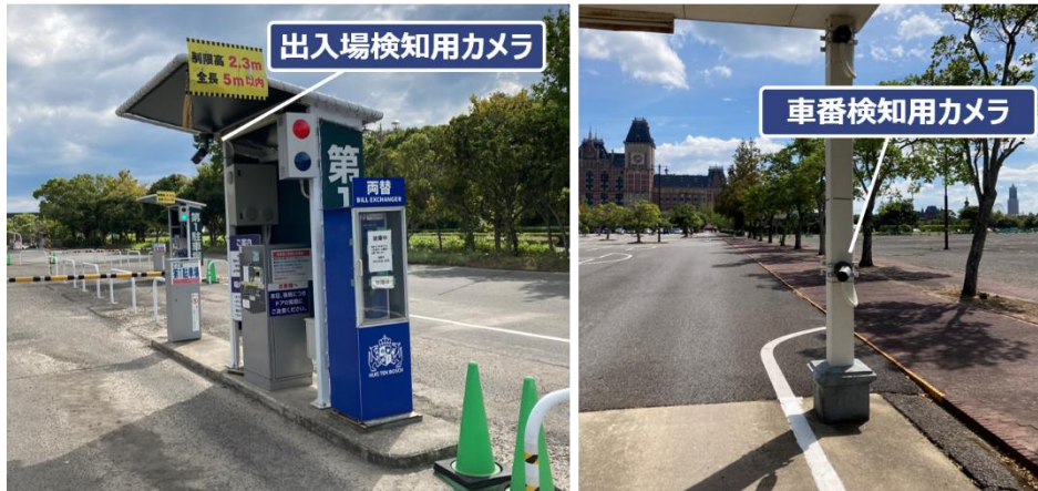
左：出入場検知用カメラ デジパーク 右：車番検知用カメラ デジスルー ハウステンボス第一駐車場
